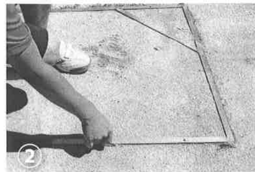
ボックスSPの外側を釘等で線を引きます
